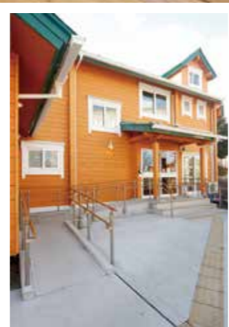
正面玄関前には緩やかな傾斜のスロープがつく。
