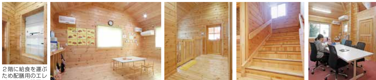
2階に給食を運ぶため配膳用のエレベーターを設置した。 1階にある3歳児室。子供たちはのびのびと過ごす。 階段上には、落下防止の柵が設置されている。 階段は、幅を広くして滑り止めを付けてもらった。 落ち着いた休憩ができる職員室。
