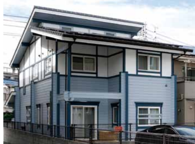
▲反対側から見る。明り取りの窓を多くした。
