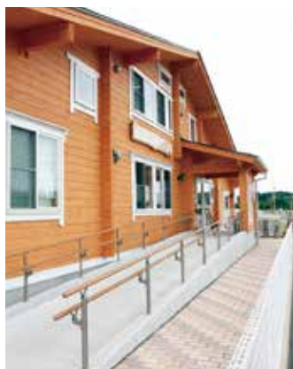
玄関にはスロープがつく。
