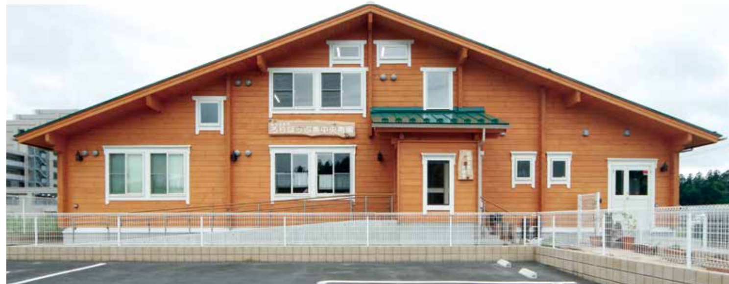
正面から見る。幅は20m超ある大きな大きなログハウス。
