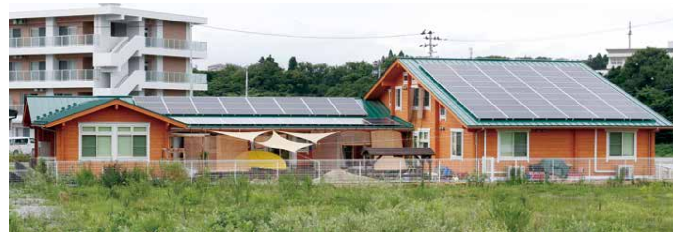
中庭側からの遠望。こちらから見た長さは約30mもある。
