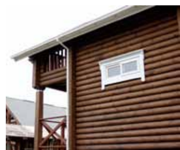
▲厚さ135mmのDログ。外側は丸太小屋の雰囲気だが内側はフラット。
